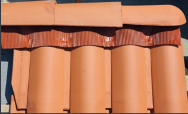
5. Posa del colmo ventilato e chiusura della linea di colmo con Coppesse e eventuali pezzi speciali. Installation of ventilator ridge Installation of last top bent tiles and closure of ridge line with special pieces.
