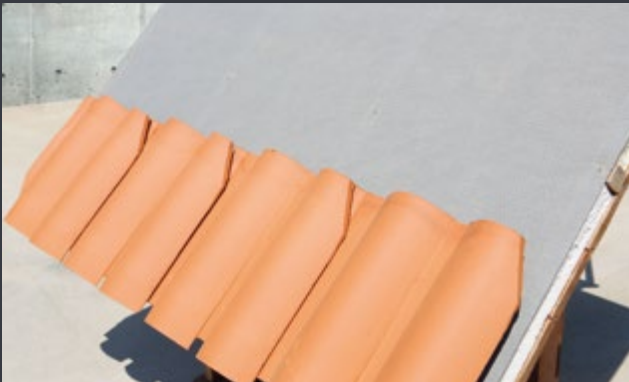
2. Posa della prima linea di ITALICA® da Destra verso Sinistra. Installation of first line of ITALICA® from right to left.
