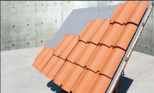
4. Posa della terza fila di ITALICA® e poi a salire allo stesso modo fino alla linea di colmo. Installation of third line of ITALICA® and then procede at the same time until ridge line.
