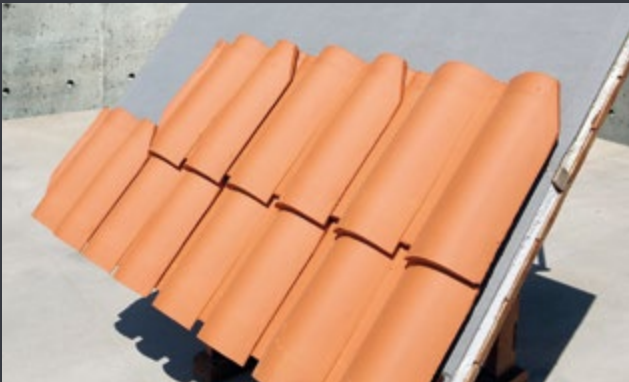
3. Posa delle seconda fila di ITALICA® da Destra verso a Sinistra. Installation of third line of ITALICA® from right to left.
